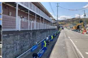
朝日方面の工事区間
